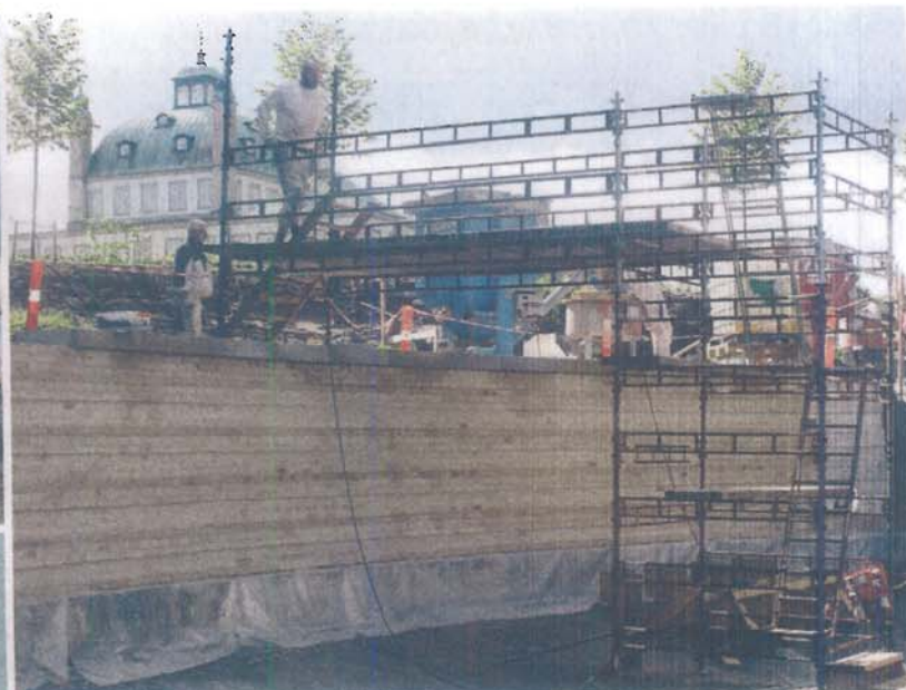
Murerformand Morten Kruse på vej på arbejde i bassinet i Fredensborg Slotshave.
